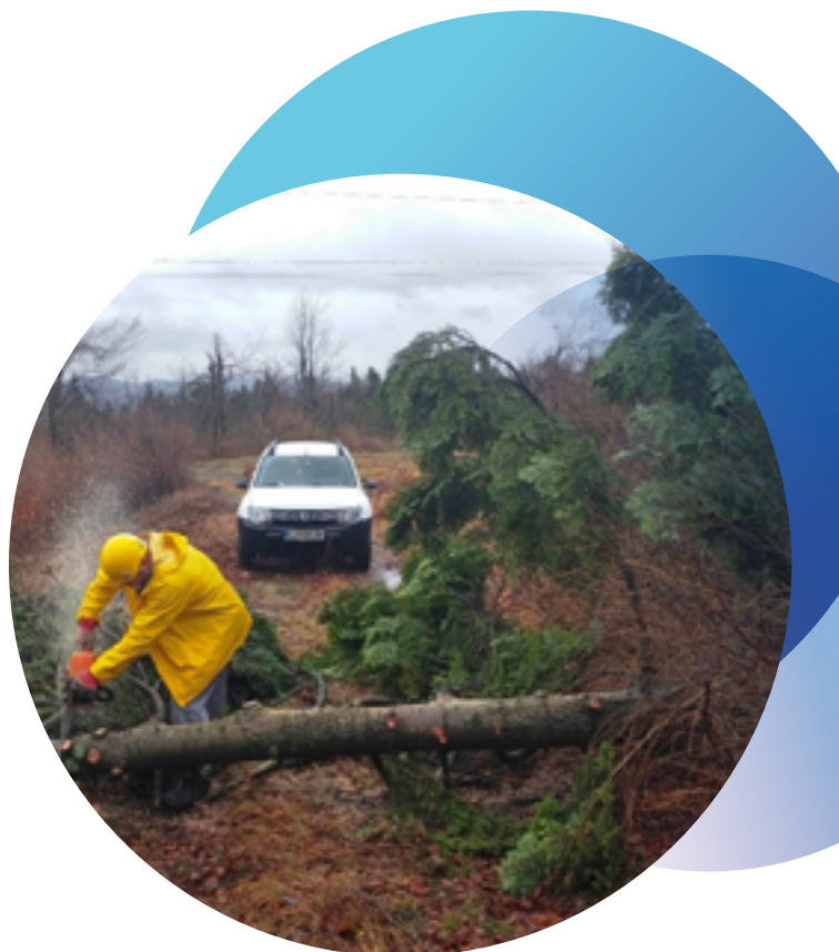
Odpravljanje škode na kabelskih povezavah
